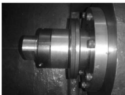
图6 碟簧的安装实况
