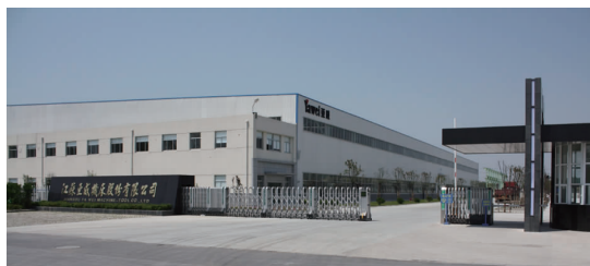
图2 黄河路厂区外观
