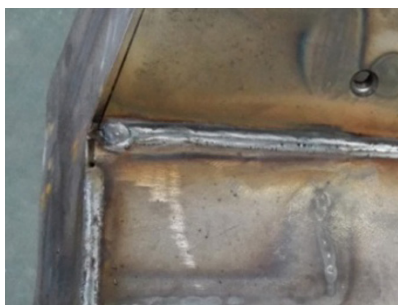
图17 A柱角焊缝
