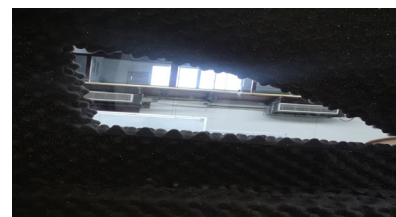
图8 声学舱海绵粘接
