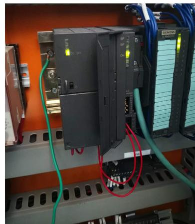
图9 搬运小车控制柜增加连接地线（绿色线）
