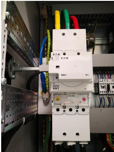
图2 机床开关处零线与地线接线
