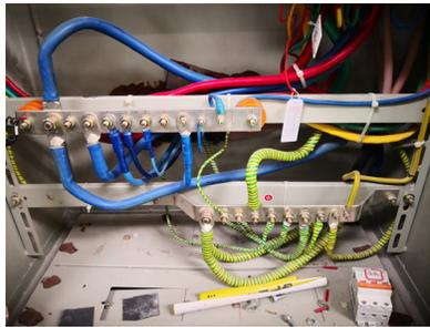
图1 配电柜零线与地线接线
