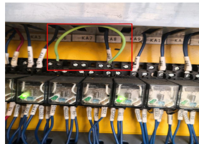
图7 KA6常闭点引入24V
