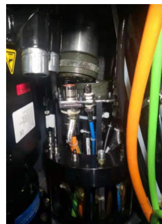
图16 拆卸摆头管线
